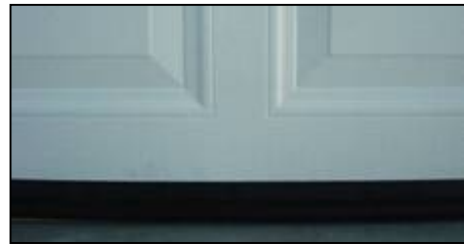
Bodendichtung am Tor montiert
