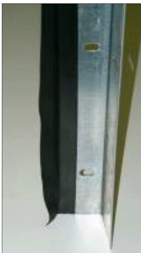
Vertikale Zarge mit Dichtung
