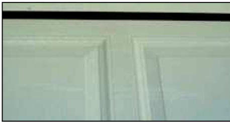
Top Dichtung am Tor montiert
